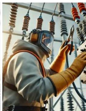
Rreziku i tensionit të lartë
